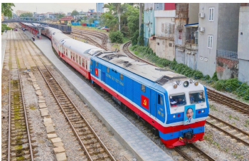
Bảo đảm khởi công Dự án đường sắt Lào Cai - Hà Nội -
